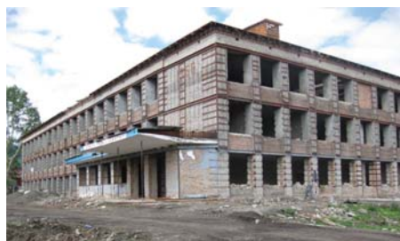
Средняя школа до реконструкции (Республика Алтай, с. Онгудай).
