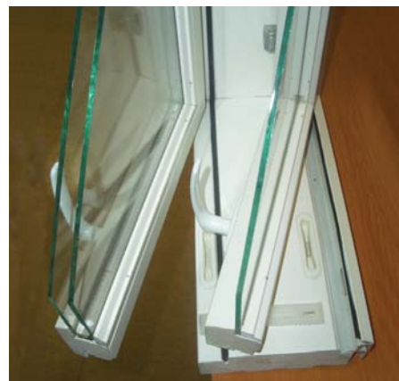
Фото 7. Деревянные оконные блоки с наружной створкой из дерева.
