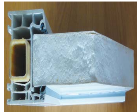
Фото 2. Применение в ПВХ профилях вместо стальных усилителей стеклопластикового армирования в коробке ПВХ профиля.
