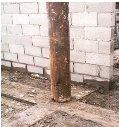
Фото 7. Вид узла сопряжения в строящемся здании и разработанный элемент узла сопряжения трубобетонной колонны с перекрытием
