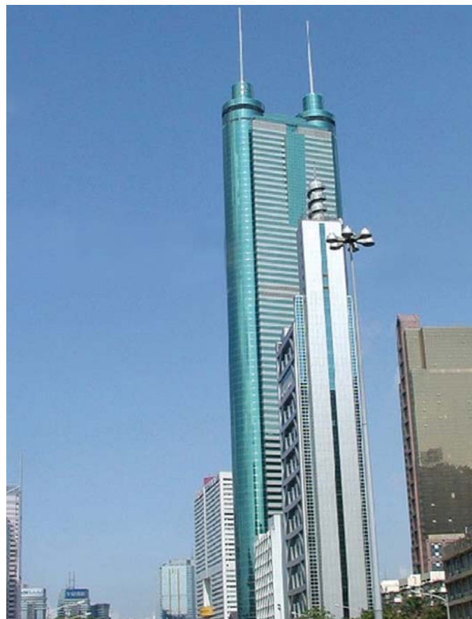
Фото 5. Здание с каркасом из трубобетона, 72 этажа (пл. Сайгэ в Шэньчжэне, КНР), построено за 15 мес.: проект проф. Цао-Шяо-Хуая — главного разработчика конструкции и технологии трубобетона в КНР (бывшего аспиранта проф. Гвоздева А. А.)
