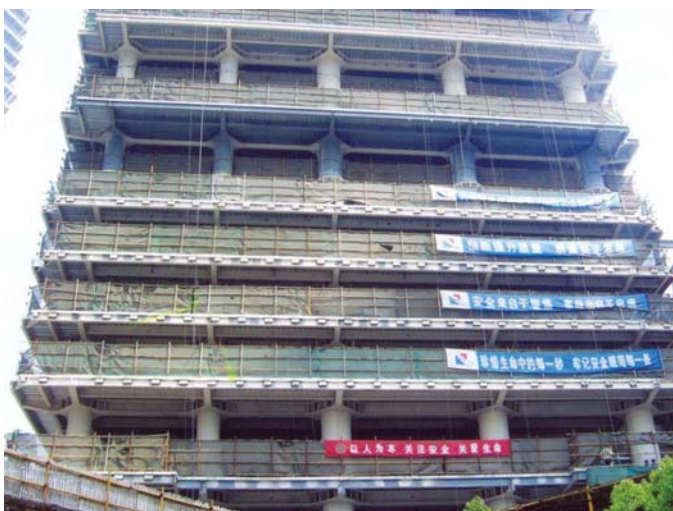
Фото 6. Высотное здание (г. Шанхай, КНР), строящееся с применением трубобетонных колонн
