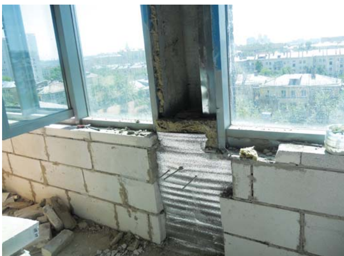
Фото 3. Замена сэндвич-панелей витражей на трехслойную конструкцию стены
