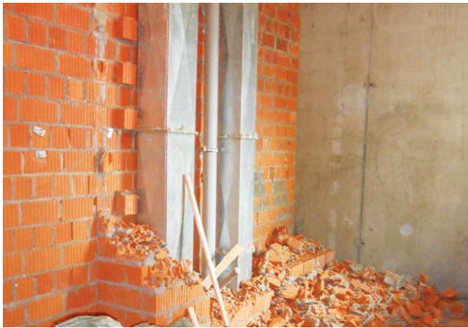
Фото 2. Демонтаж вентиляционных воздуховодов
