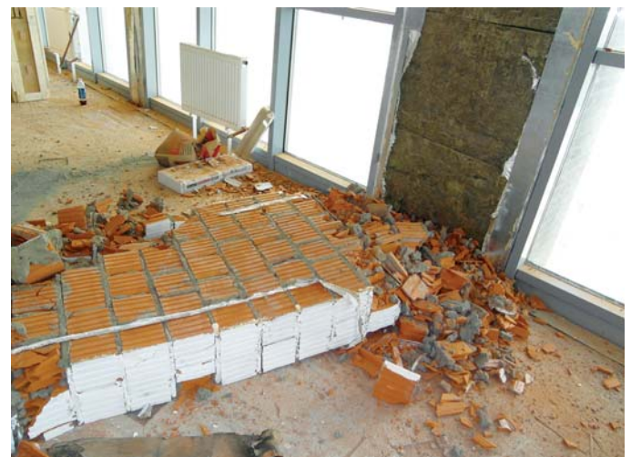
Фото 4. Демонтаж внутреннего слоя трехслойных наружных стен
