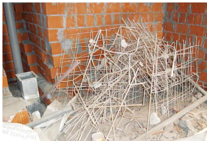
Фото 5. Удаление гибких связей и сеток армирования кладки многослойных конструкций
