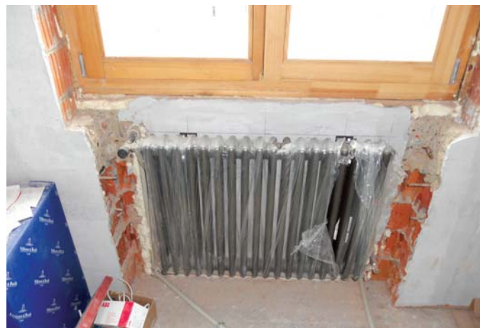
Фото 6. Частичный демонтаж внутреннего слоя многослойной наружной стены с установкой блока отопления
