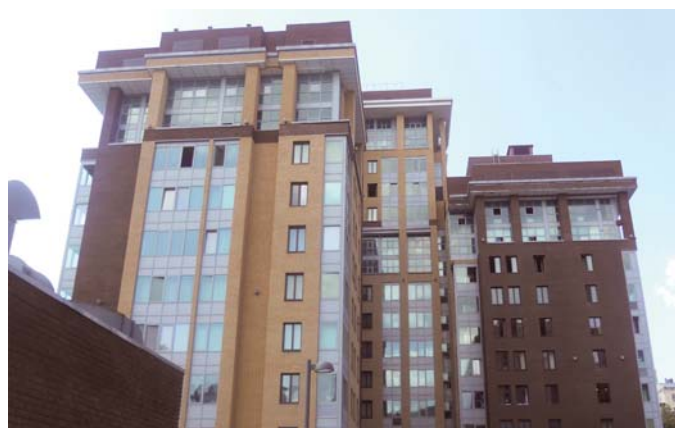
Фото 1. Общий вид жилого здания
