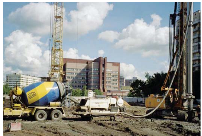
Фото 4. Бетонирование сваи, устраиваемой по технологии DDS с использованием бетононасоса Mesbo
